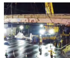
歩道橋の解体撤去風景
