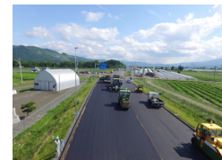
▲ H30年度 旭川十勝道路 富良野市 上五区舗装工事
