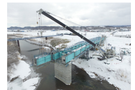
▲ H31年度 八雲今金線(B地-230)工事(上部架設)
