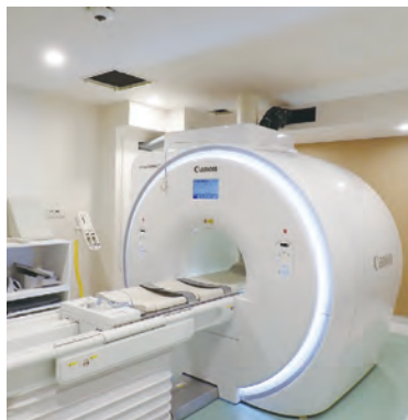
MRI室冷水装置配管改修工事
