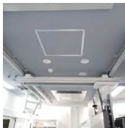
アンギオ室天井補修工事
