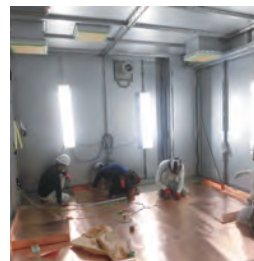
電波シールド工事床銅板はり
