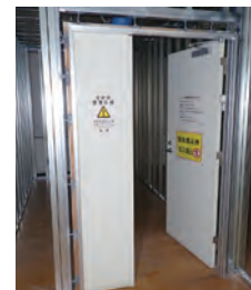
レントゲン室工事
