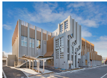
領家公民館・領家保育園改築工事(川口市) 川口市発注の大型公共施設
